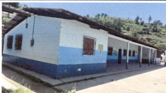
Foto 3: Pintura en muros exteriores aulas modulo 1
